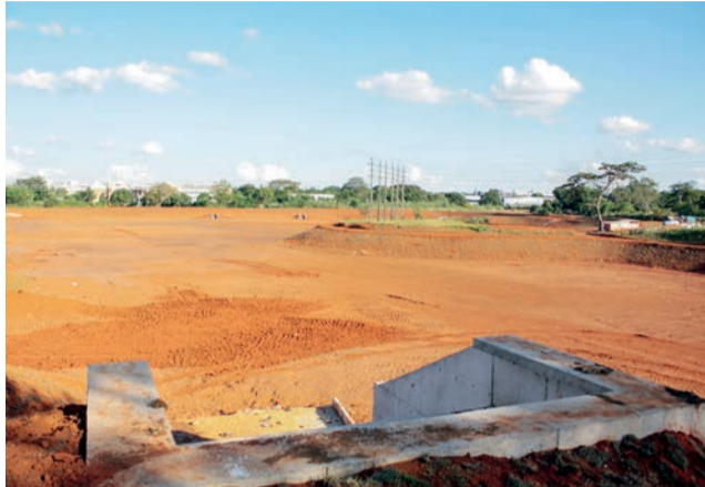
Obra amplia o sistema da rede de drenagem no Parque da Cidade e está associada à construção do viaduto da Epig
