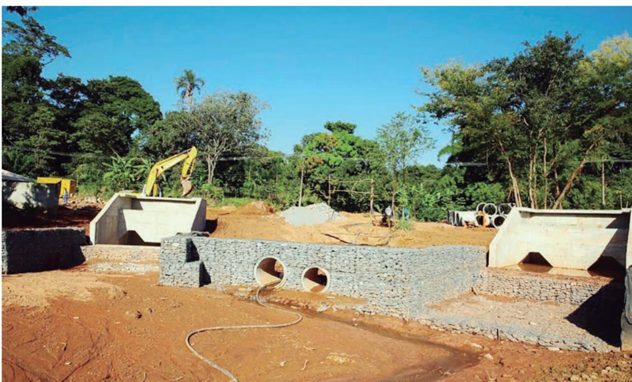
Sistema de drenagem está sendo construído para captar água das chuvas no Eixo Leste-Oeste 5
