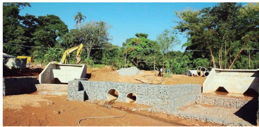
Sistema de drenagem está sendo construído para captar água das chuvas no Eixo Leste-Oeste 5
