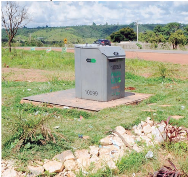
Equipamento tem capacidade para recolher até 5 m 3 de lixo residual das residências
