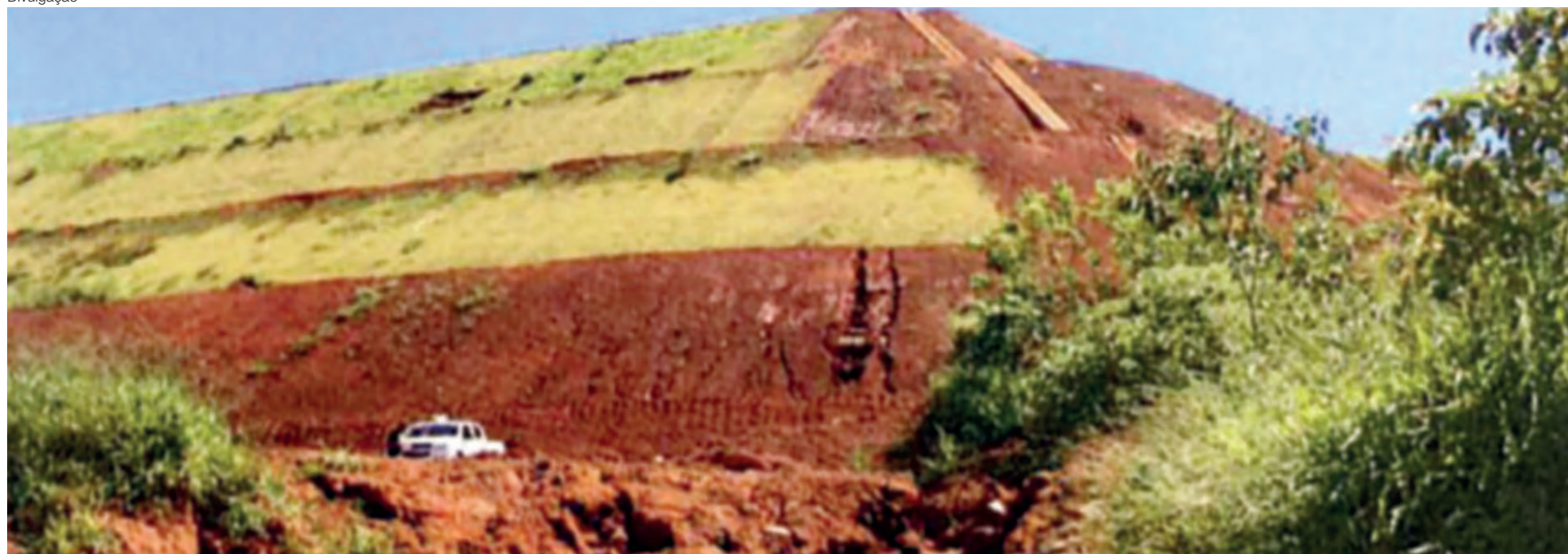
Foto feita pela Dema em fiscalização realizada em 2016
