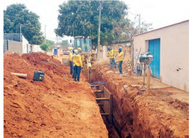
Obras de implantação de rede no Bairro Pontal Sul
