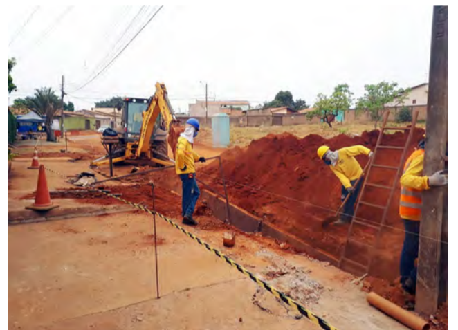
Obras de implantação de rede no Bairro Veiga Jardim
