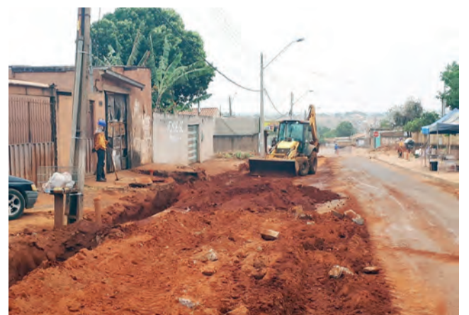
Obras de implantação de rede no Bairro Vila Oliveira
